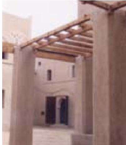
Ksar Jranat, Erfoud (Réhabilitation par Al Omrane).
