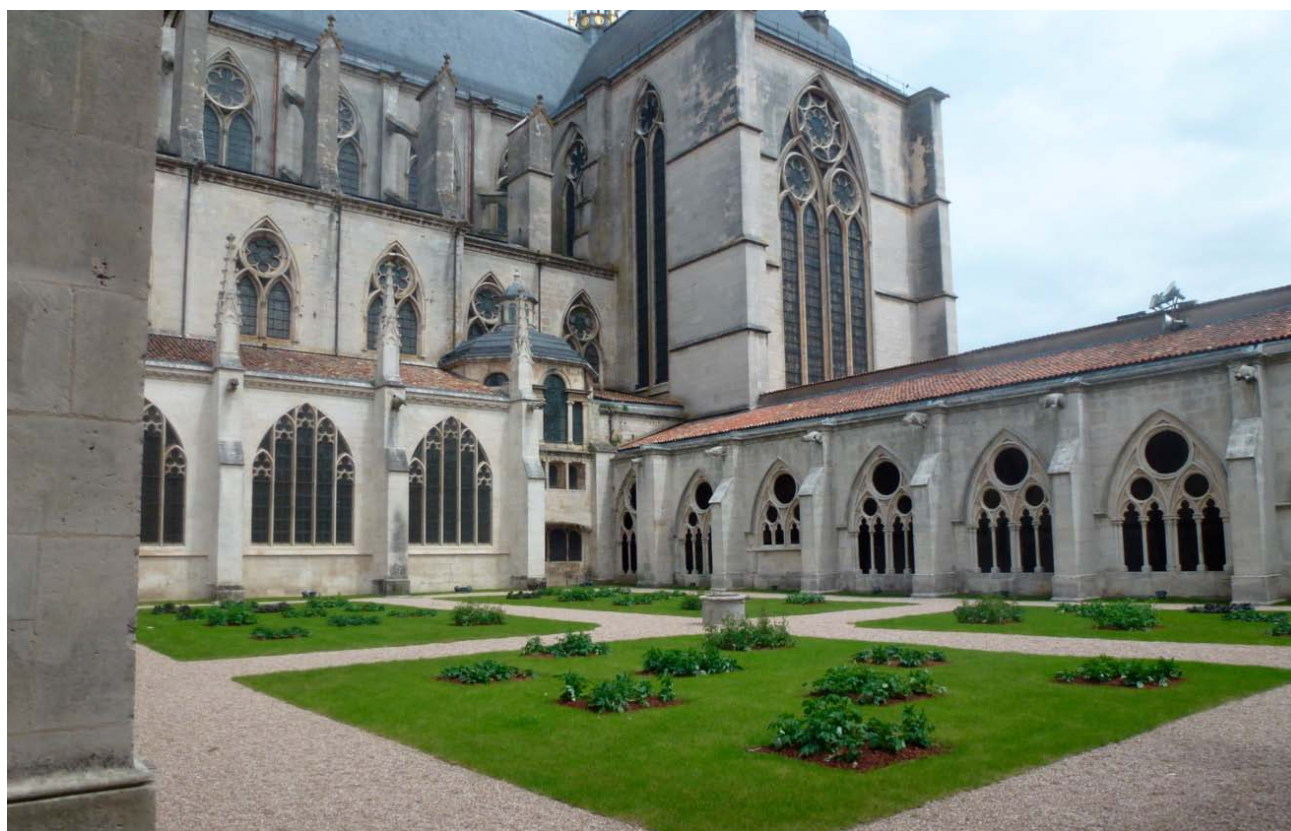
Vue du cloître après les travaux (angle nord/est).
