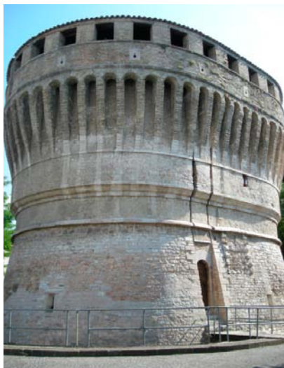
La torre inferior, recién restaurada.
