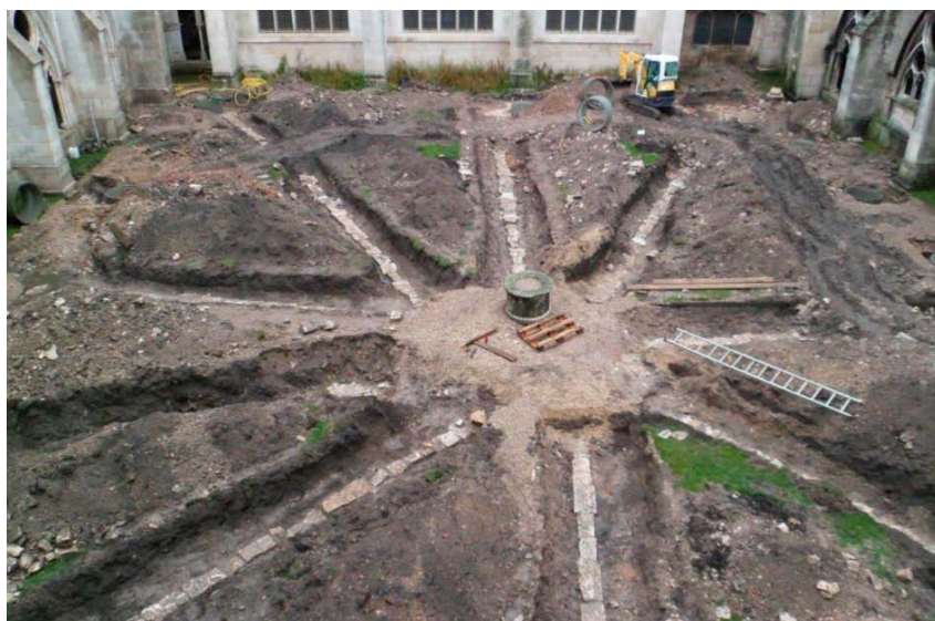
En cours de travaux, vue du réseau d'assainissement médiéval.
