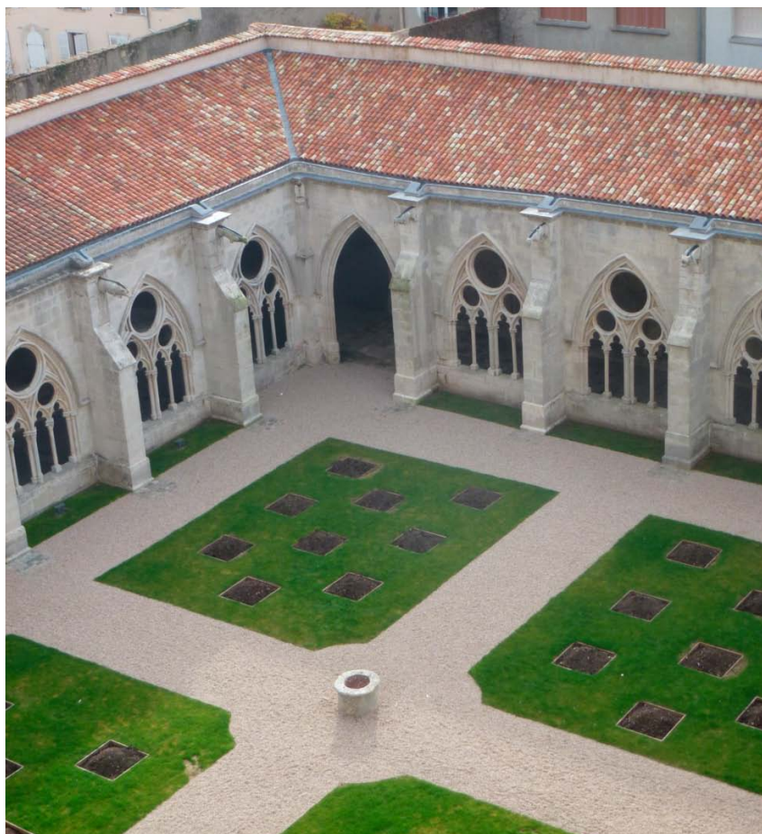
Vue du cloître après les travaux (angle sud/ouest).
