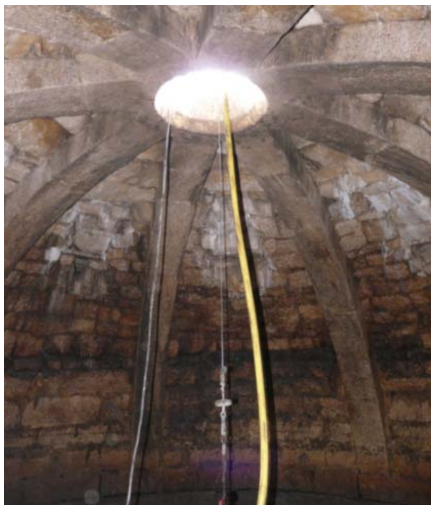
Vue de l'intérieur de la citerne.
