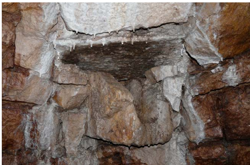
Intérieur de la citerne, détail d'un exutoire.
