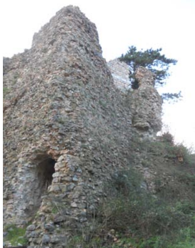
La torre superior, reducida a núcleo, con fragmentos en opus listatum .
