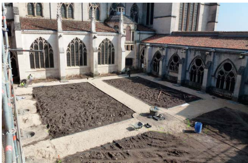
Vue du cloître après la remise en service du réseau d'assainissement.
