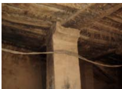
Dégradation du plancher au niveau de l'entrée du ksar Ayt Yahya Ou'atman.
