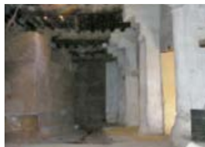
A gauche, structure originale des contreforts dans l'espace des ablutions ; à droite, structure de piliers en béton armé, ksar Ayt Yahya Ou'atman.
