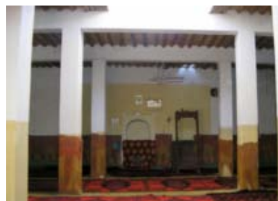
A gauche, structure originale des contreforts dans l'espace des ablutions ; à droite, structure de piliers en béton armé, ksar Ayt Yahya Ou'atman.
