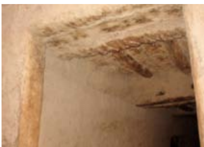
Eléments de renfort en bois de palmier ; bande de bois pour la stabilité des fissures.
