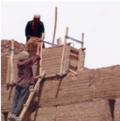
Technique du pisé et du adobe : brique de terre crue. Source : Conservation manual for Earth Architecture in the pre-Saharan valleys of Morocco CERKAS / UNESCO World Heritage Centre / CRATerre-EAG, 2005. Murs en terre crue : pisé et brique de terre.
