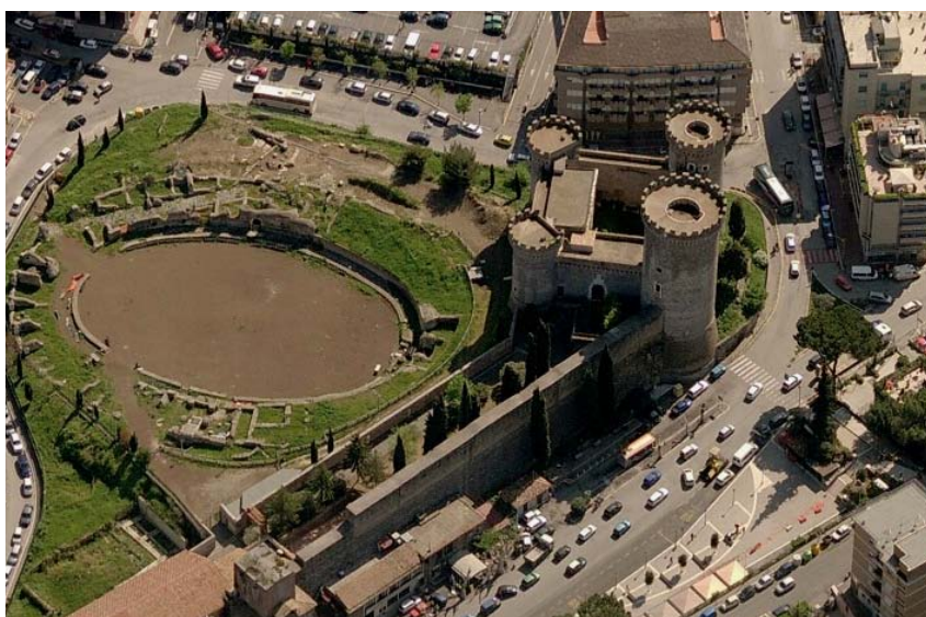
La Rocca Pia, en una foto aérea anterior a la obra de restauración. Del lado izquierdo, el Anfiteatro romano de Bleso.
