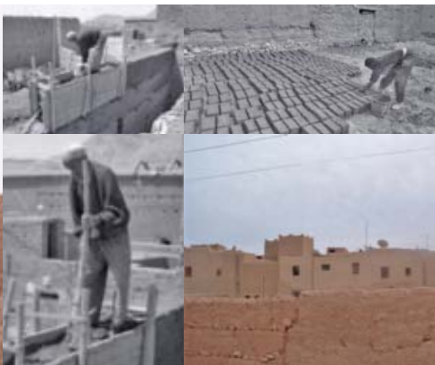
Technique du pisé et du adobe : brique de terre crue. Source : Conservation manual for Earth Architecture in the pre-Saharan valleys of Morocco CERKAS / UNESCO World Heritage Centre / CRATerre-EAG, 2005. Murs en terre crue : pisé et brique de terre.
