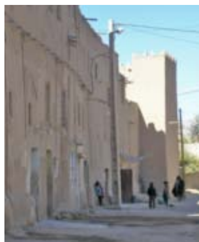
Nouvelles ouvertures dans les remparts.
