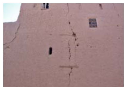
Technique du pisé et du adobe : brique de terre crue. Source : Conservation manual for Earth Architecture in the pre-Saharan valleys of Morocco CERKAS / UNESCO World Heritage Centre / CRATerre-EAG, 2005. Murs en terre crue : pisé et brique de terre.
