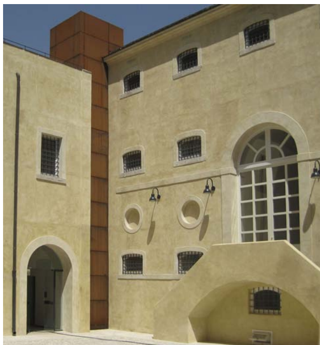
Fachadas del patio principal de la Rocca Pia, antes y después de la restauración de las superficies, con técnicas y materiales tradicionales. En la imagen de la derecha, al centro, se nota el nuevo volumen del ascensor, revestido con láminas de acero corten.
