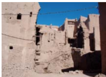
Dégradation du plancher au niveau de l'entrée du ksar Ayt Yahya Ou'atman.
