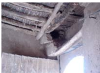
Dégradation du plancher au niveau de l'entrée du ksar Ayt Yahya Ou'atman.
