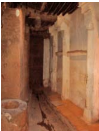
Structure originale des contreforts dans l'espace des ablutions.
