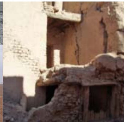
Technique du pisé et du adobe : brique de terre crue. Source : Conservation manual for Earth Architecture in the pre-Saharan valleys of Morocco CERKAS / UNESCO World Heritage Centre / CRATerre-EAG, 2005. Murs en terre crue : pisé et brique de terre.
