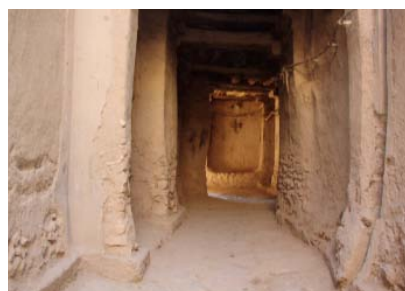
Rue principale et structure des piliers engagés dans les murs, ksar Ayt Yahya Ou'atman.
