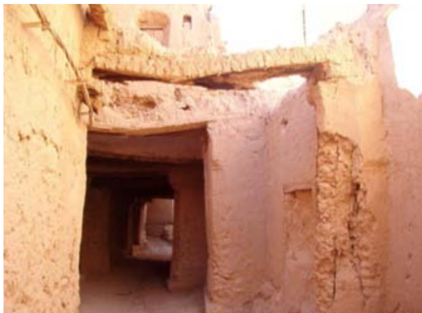
Effondrement de plancher sur ruelle, ksar Ayt Yahya Ou'atman.
