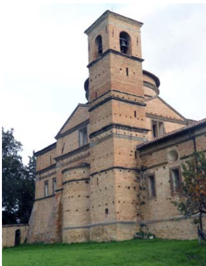
Fachada sureste con contrafuertes (Foto S. Gizzi, 2012).
