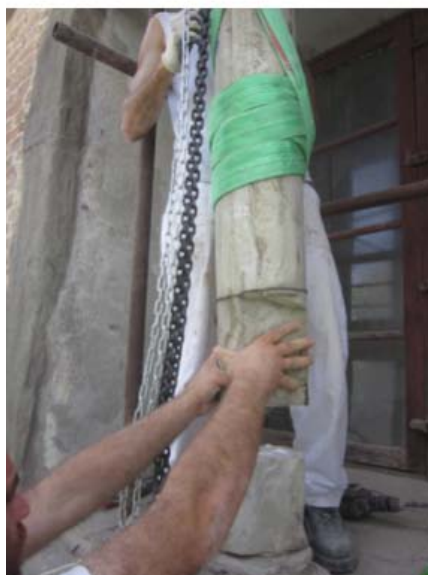
Fases de la restauración de la columna (Foto Gamma s.r.l. Fano, 2015).
