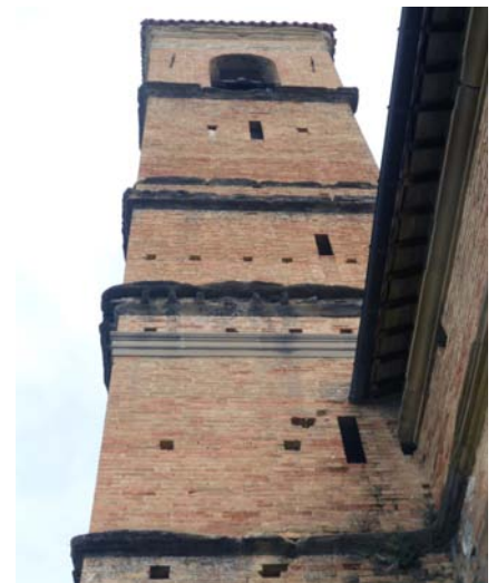
Torre campanaria con cornisas originales y de restauración (Foto S. Gizzi, 2012).
