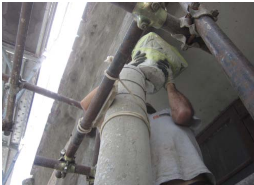
Desmontaje del capitel de la columnilla de la ventana bifora del frente principal (Foto Gamma s.r.l. Fano, 2015).
