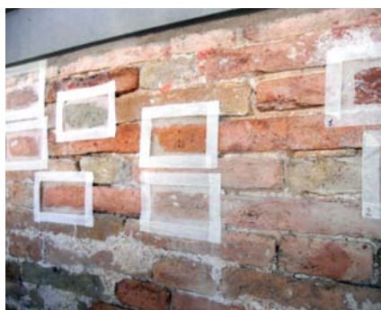
Pruebas de consolidación de los ladrillos y test de tratamiento del mortero (Foto S. Gizzi, 2015).
