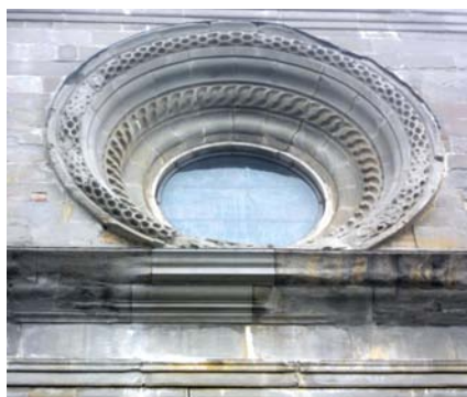
Deterioro y reintegraciones de la piedra arenisca de la iglesia de Santa María de las Gracias al Calcinato en Cortona (Foto S. Gizzi, 2012).
