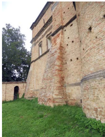
Detalle de los contrafuertes en mampostería (Foto S. Gizzi, 2012).
