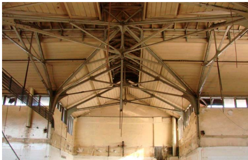
La estructura de la cubierta.
