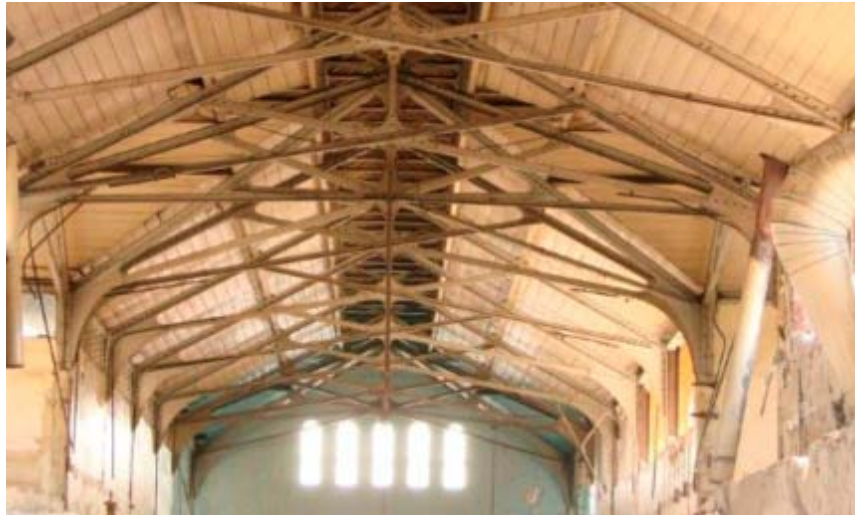
Detalle de la estructura de cubierta.
