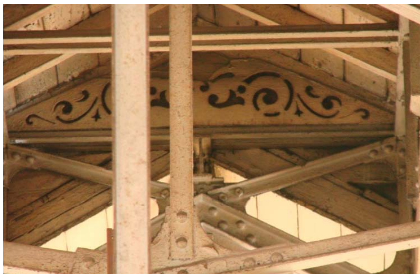
Vista general de la estructura de cubierta.
